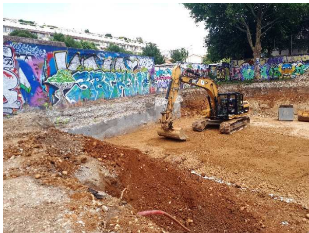
Réalisation des terrassements
