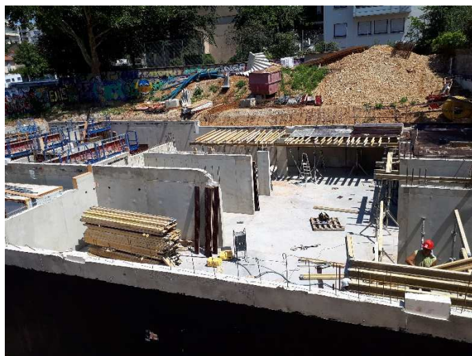
Démarrage du gros œuvre : dalle et élévations du sous-sol
