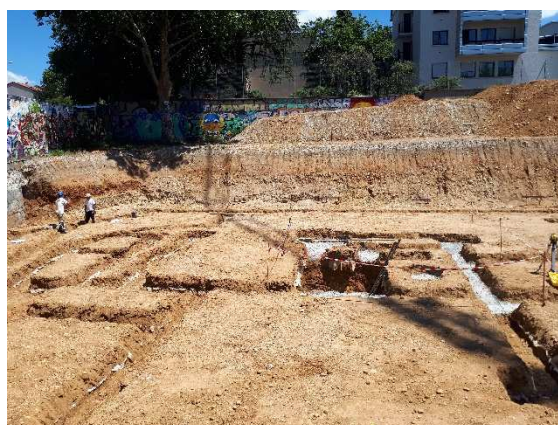
Réalisation des fondations
