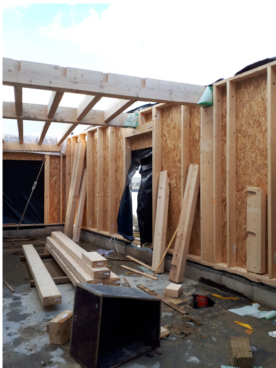
Pose de la structure bois (en haut à gauche) Pose des menuiseries extérieures et du système d'accroche des balcons métalliques (en haut à droite) Pose des cloisons intérieures (à droite)
