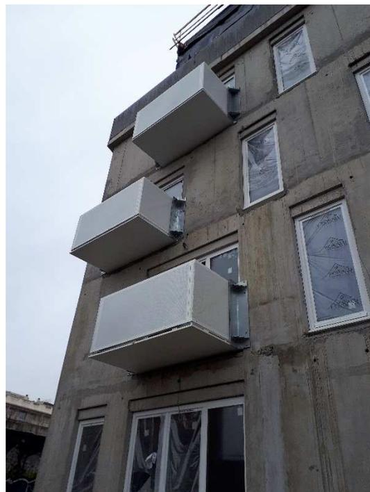
Pose des balcons (haut), isolation extérieure des logements en structure bois (bas à gauche), prototype du bardage briques (bas à droite)
