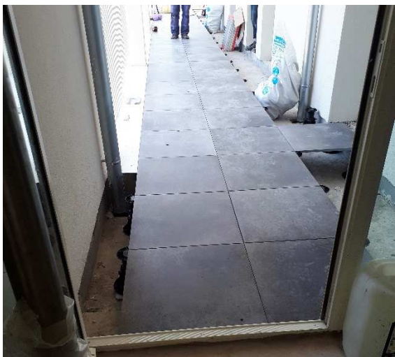
Réalisation des coursives
