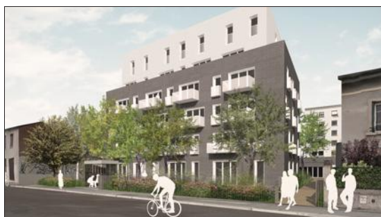
■ Le bâtiment sera réalisé rue Philippe-de-Lassalle. Photo Tectone-architecte associé : Detry & Levy.
