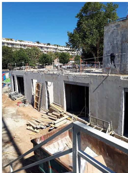
Réalisation des murs béton du rdc
