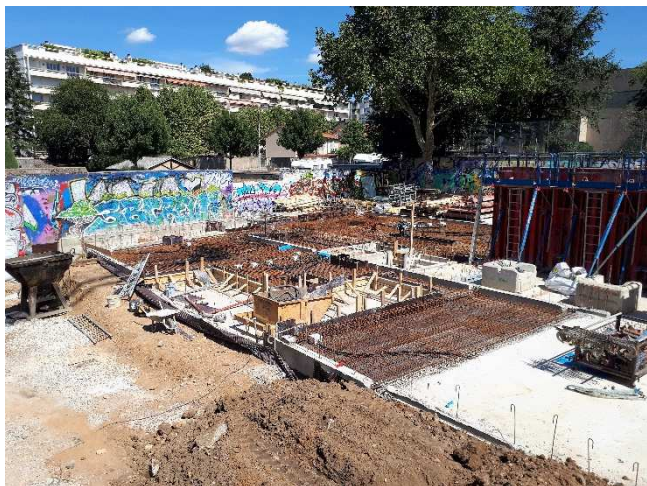
Ferrailage et coulage dalle du rdc
