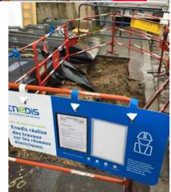
10/04/18 – Suppression du branchement électrique de la maison à démolir par ENEDIS
