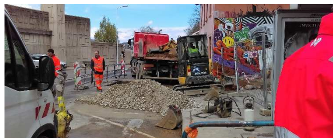
10/04/18 - Création branchement à l'assainissement par le Grand Lyon
