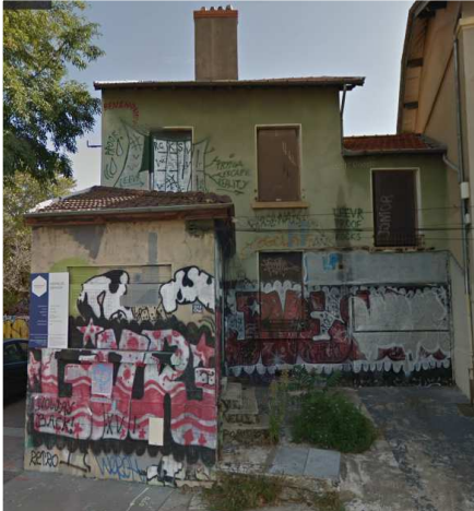
03/04/18 – Désamiantage de la façade avant/après avec échafaudage confiné
